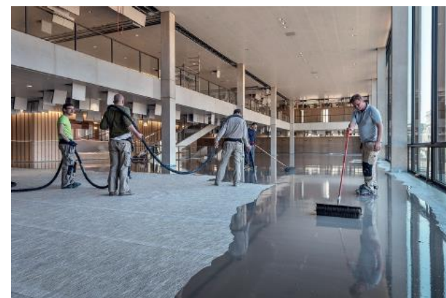
Prestierkovaný UZIN RR 201 stierkovacou hmotou UZIN NC 170 LevelStar pomocou čerpacej techniky
